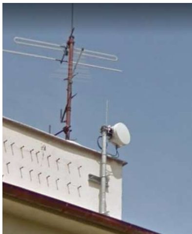
Mikrovlnná anténa T-mobilu
